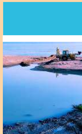
La desembocadura del río en muchas ocasiones está cegada por la arena de la playa por lo que los vertidos se acumulan hasta que desbordan la flecha de arena o hasta que se procede a la apertura de un canal hacia la bahía.
